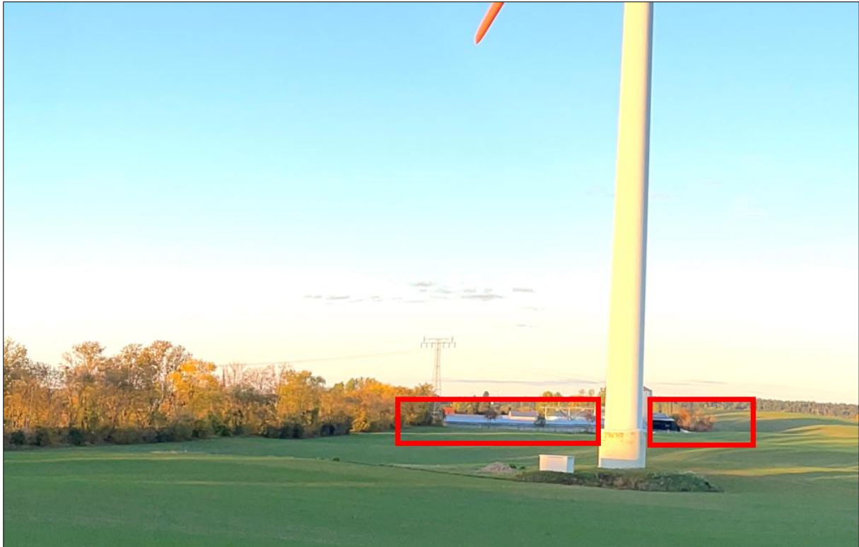
Abb. 5 Blick von Süden: Geltungsbereich (rot), Hochspannungsleitung und WKA; das SPA beginnt westlich hinter den Bäumen
